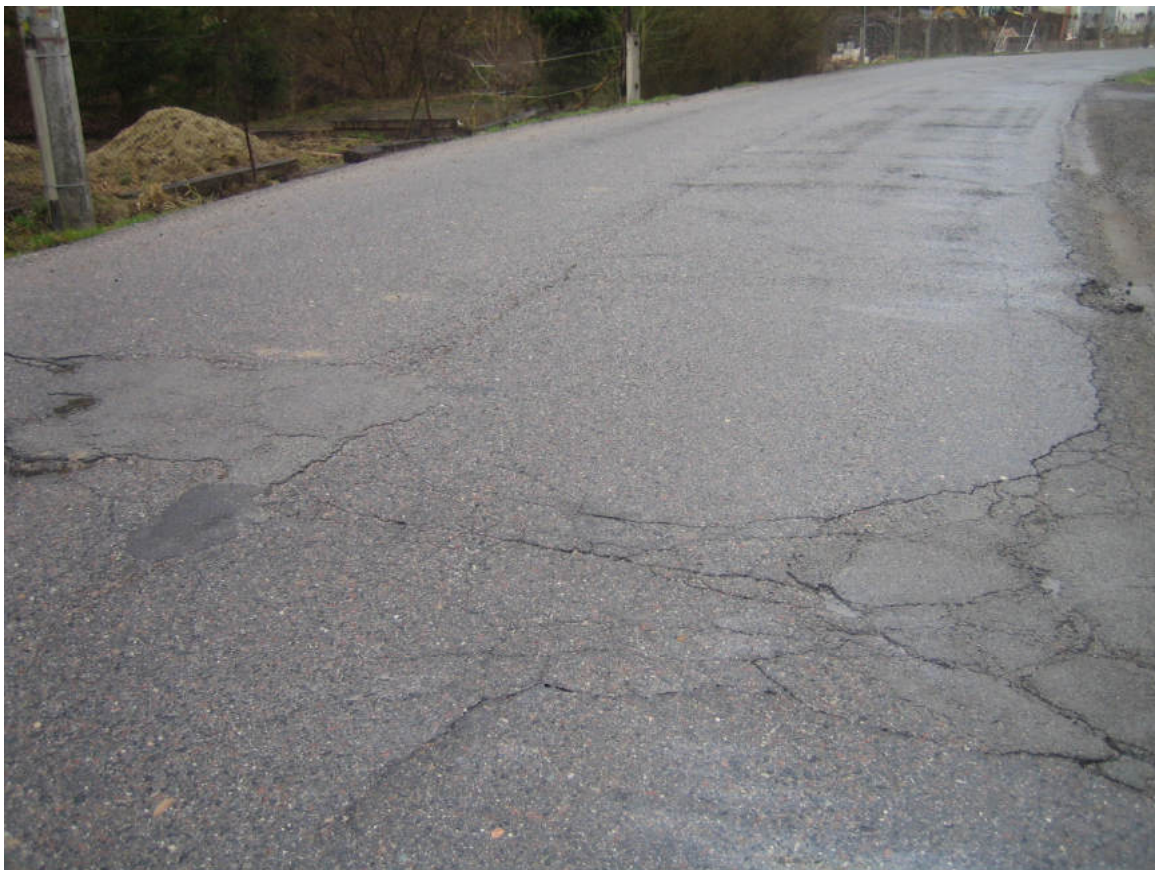
F13, km 0,600- Mozaikové až síťové trhliny, příčná rozvětvená trhlina, vysprávkky a nepravidelné hrboly, olamování okraje vozovky
